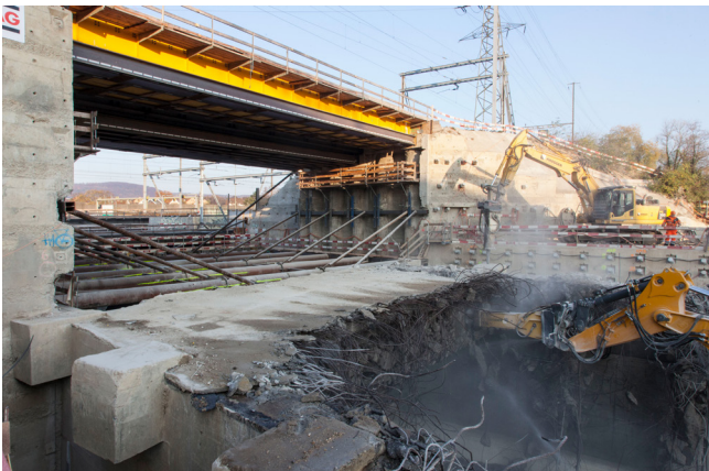
Abbruch Rahmentragwerk und alter Tunnel Hagnau
