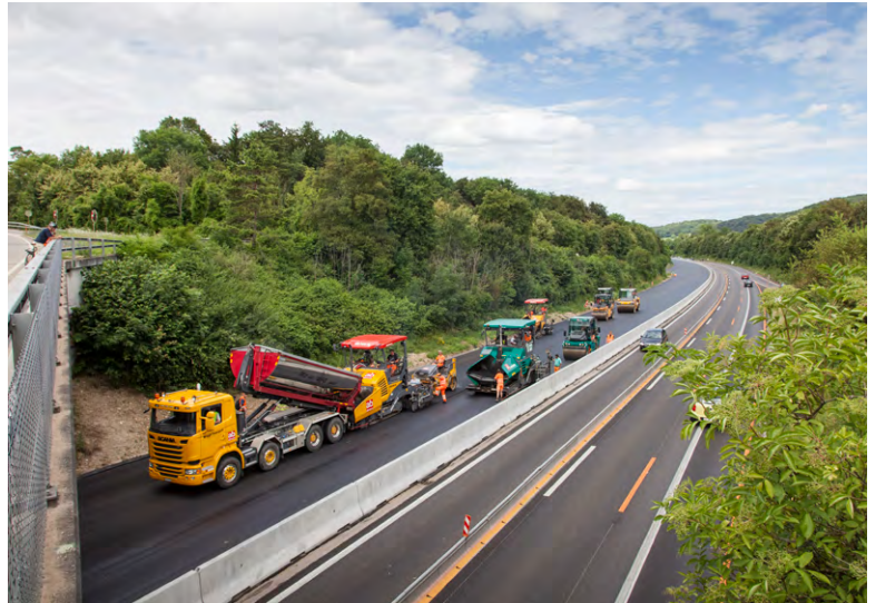
Übersicht Belagseinbau Fahrtrichtung Delémont
