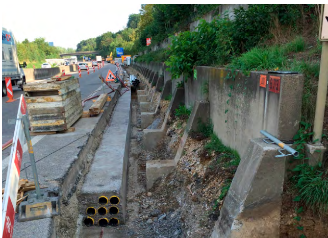
Erstellen neuer Kabelrohrblock
