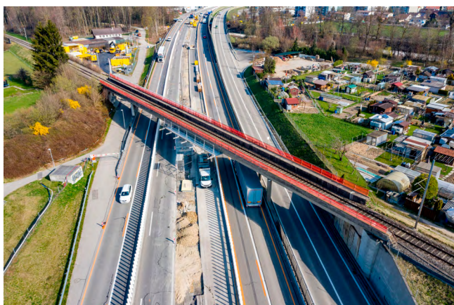
Bauphase 2 – Mittelstreifen mit Instandsetzung Eisenbahnbrücke Z18
