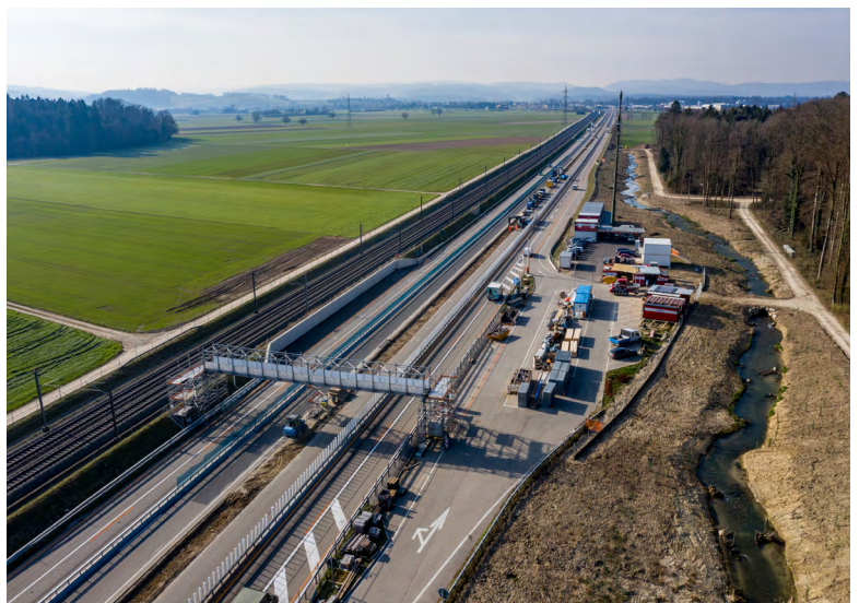
Hauptinstallationsplatz beim Rastplatz Chölfeld und Umlegung Oberholzbach
