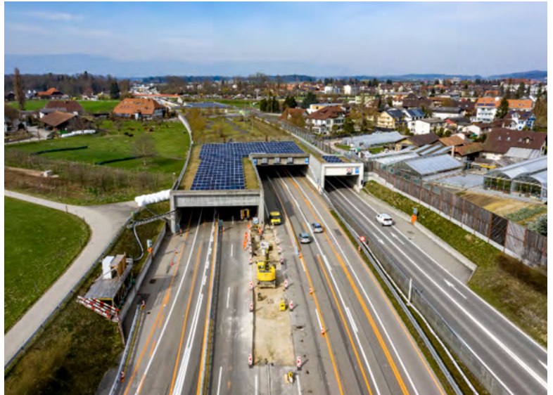
Temporäre Verkehrsführung Vorzone Portal Süd Tunnel Alchenflüh - Z17
