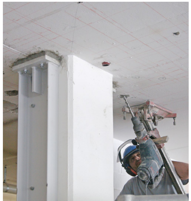
Durchstanzertüchtigung bei Innenstütze mit Durchstanz-Dübel
