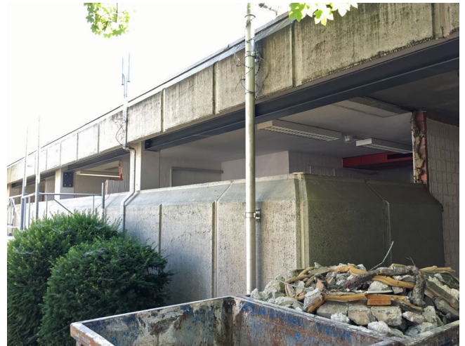
Durchstanzertüchtigung am Deckenrand mit Stahlträger
