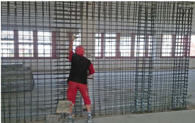
Erdbebenertüchtigung Innenwand Mittelteil zur Aussteifung
