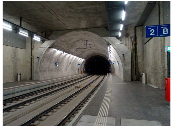
Feste Fahrbahn beim Champel-Tunnel
