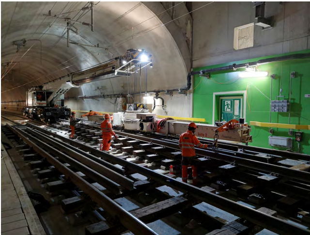
Weicheneinbau beim Bahnhof Eaux-Vives
