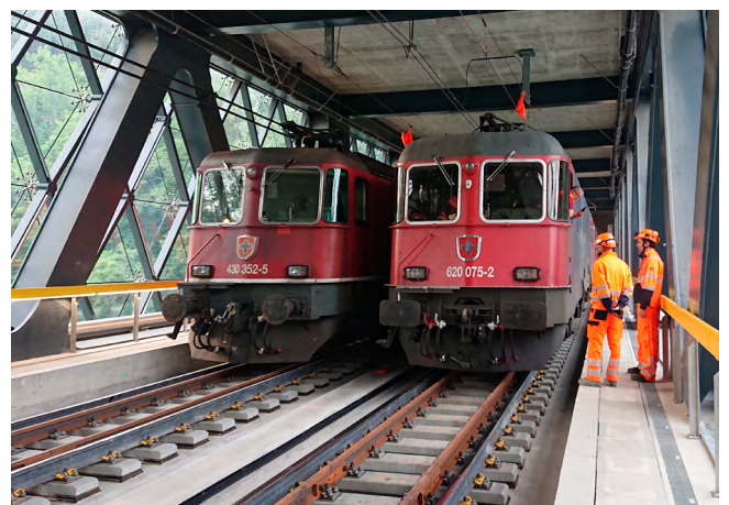
Belastungsproben auf der Val d'Arve-Brücke
