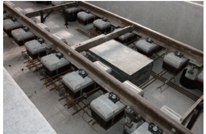
Mittelschacht mit Bewehrung
