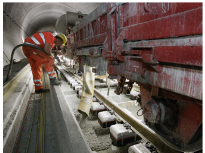
Einbau Gleis-tragplatte, Vergussbeton
