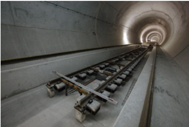
Gleisrost System LVT mit Schwellenblock im Gummischuh
