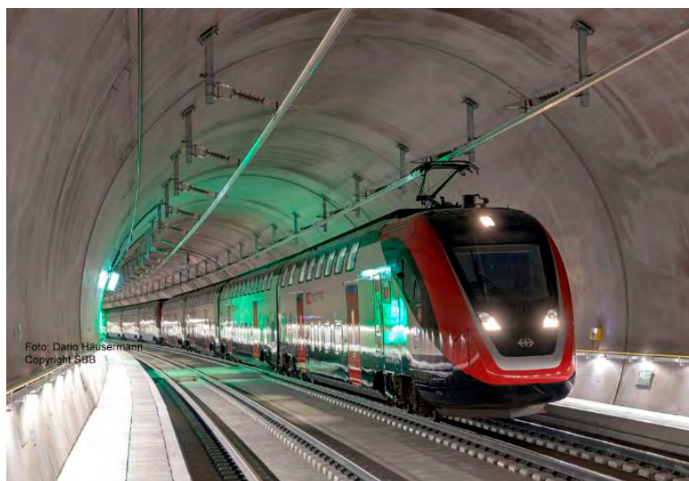
Eppenbergtunnel in Betrieb
