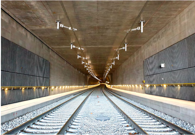
Feste Fahrbahn im Endzustand
