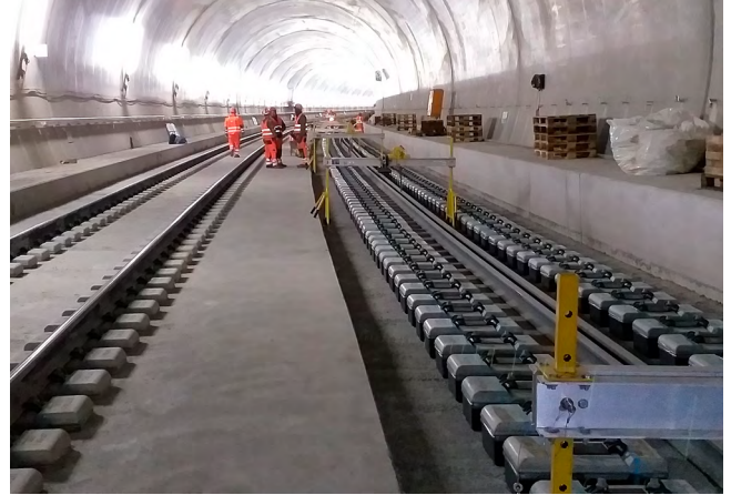
Feste Fahrbahn im Bauzustand
