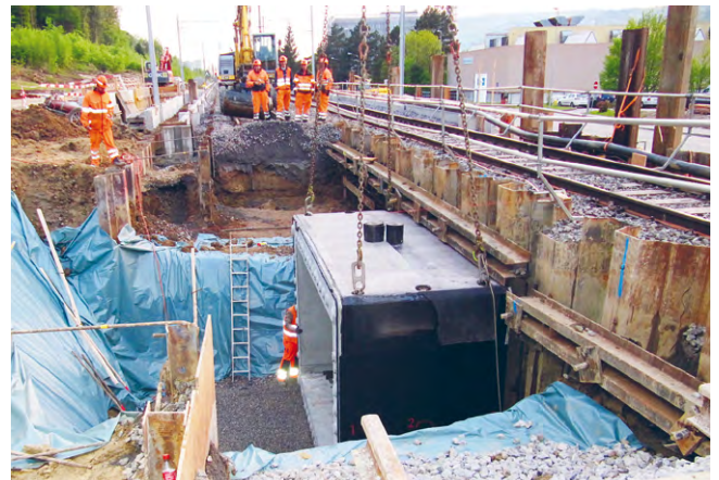
Einbau Personenunterführung
