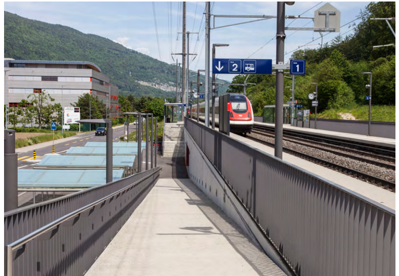
Ansicht Zugangsrampe und Perron
