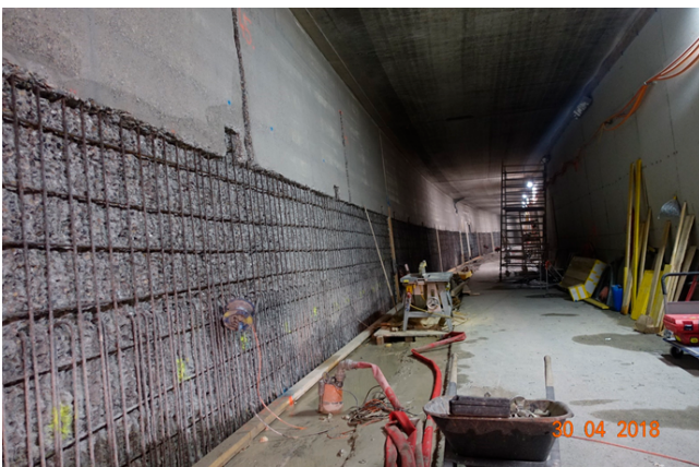
Betonabtrag Tunnelwand h < 2 m
