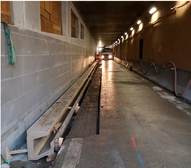
Neubau Bankette – Entwässerungsrinnen aus Polymerbeton
