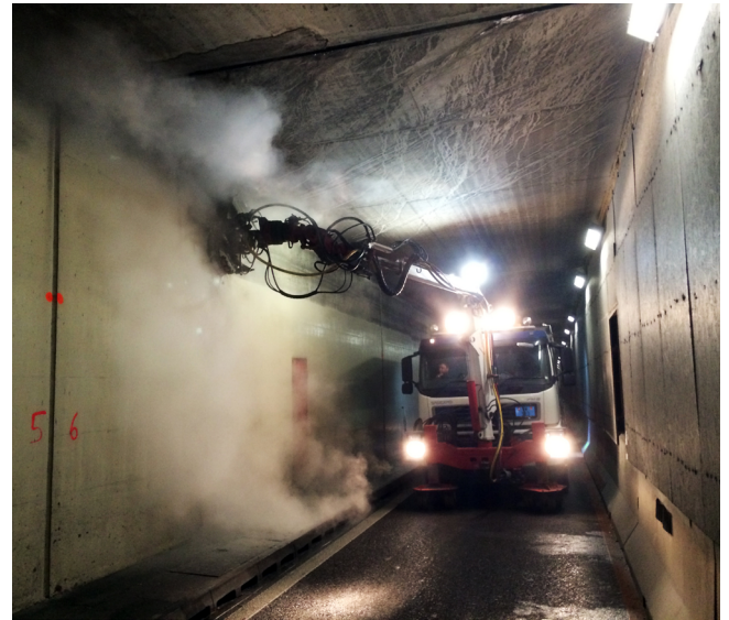
Abtrag der bestehenden Wandbeschichtung
