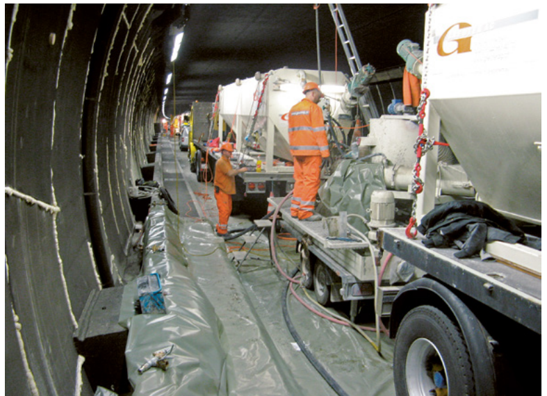
Das Mischen des Injektionsmaterials erfolgte vor Ort
