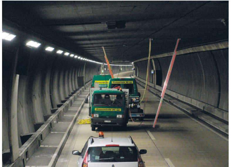
Hohlraumhinterfüllung im Firstbereich
