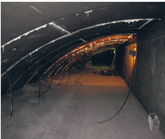
Ansicht Zwischendecke nach Hinterfüllung
