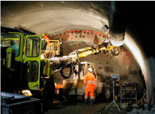
Kalottenvortrieb, doppelter Rohrschirm
