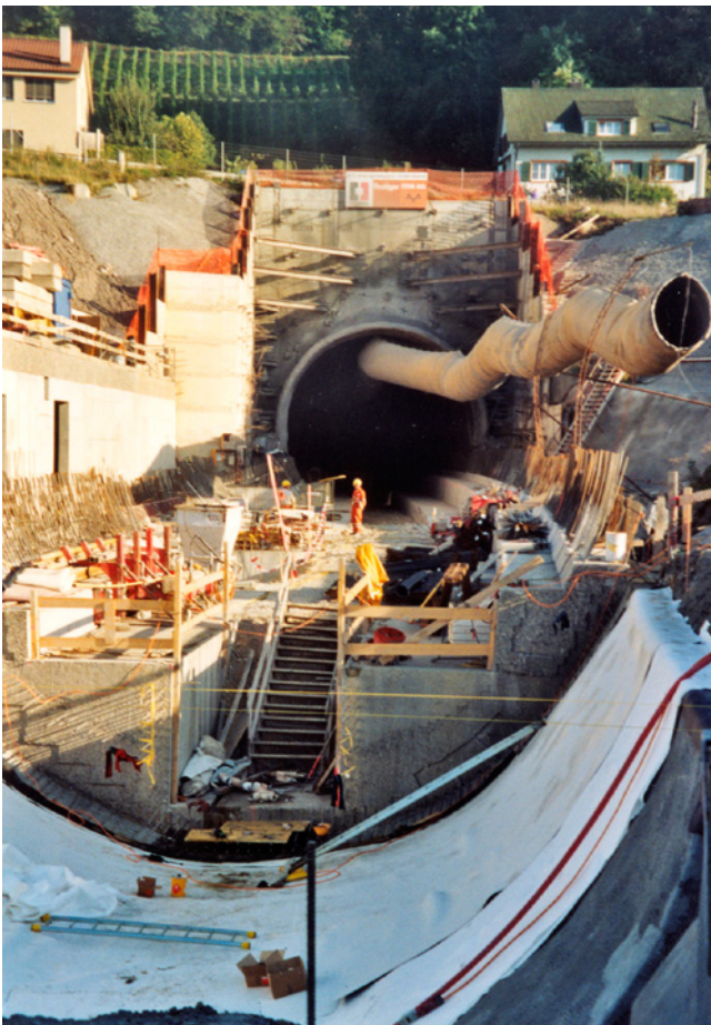
Baugrube Tagbautunnel Ost
