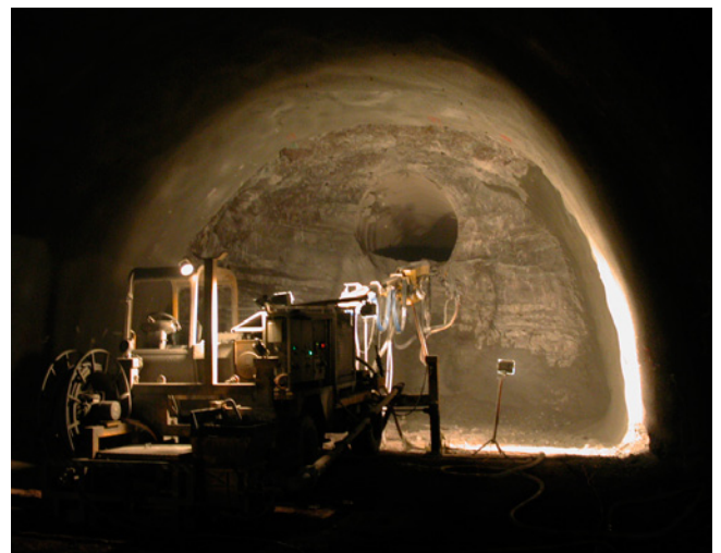
Kalotte mit Pilotstollen
