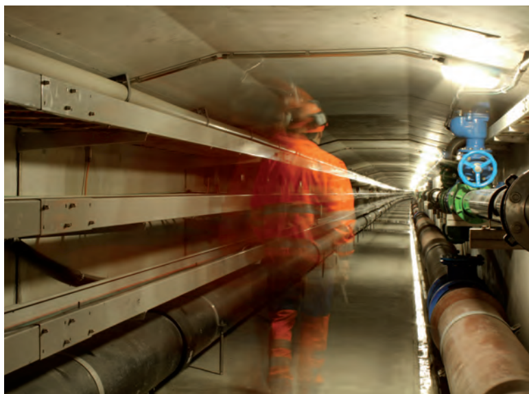
Werkleitungskanal als Fluchtweg
