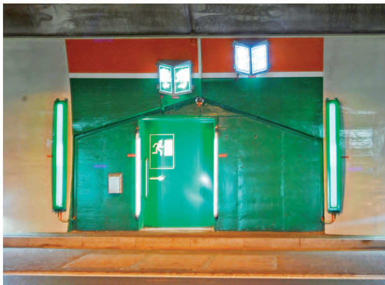
Ansicht von einem der drei neuen Fluchtabgänge
