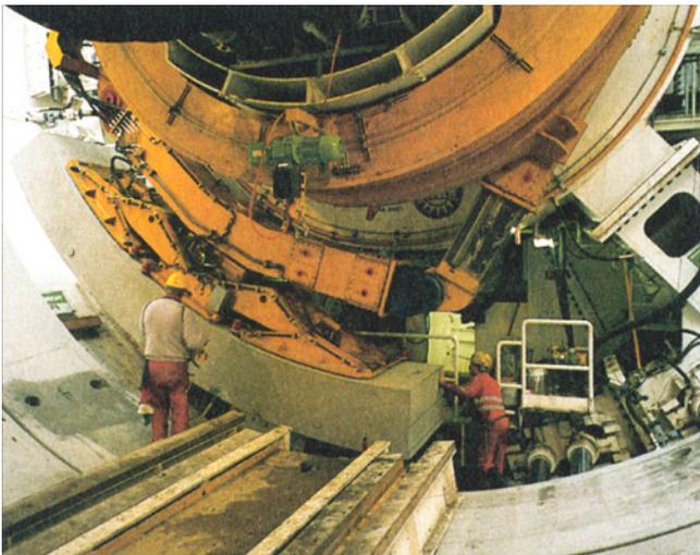
Der Tübbingeinbau erfolgt 10 m hinter dem Bohrkopf
