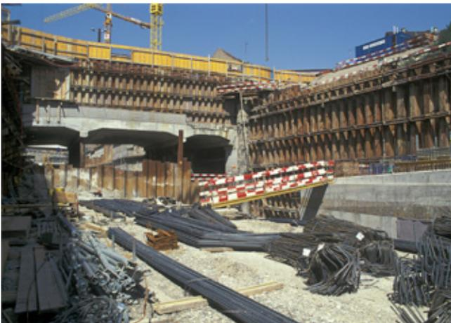
Tunnelquerschnitt und rückverankerte Spundwand
