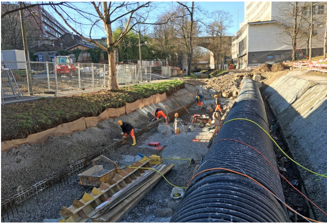
Aufwertung der Betonsohle mit Blocksteinen
