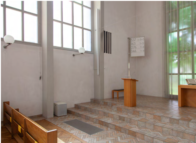
Optisch kaum bemerkbar: Lautsprecher an der Säule und Subwoofer am Boden
