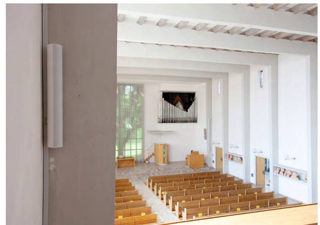
Hinterer Säulenlautsprecher auf der Empore
