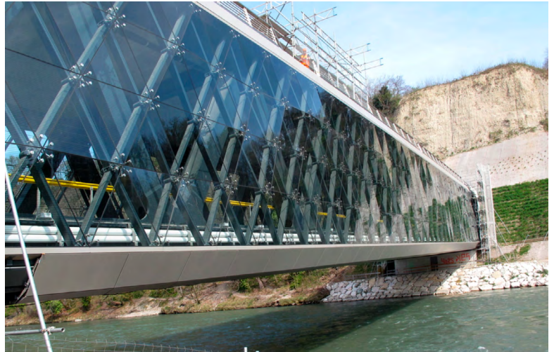
Ansicht der Val d'Arve Brücke
