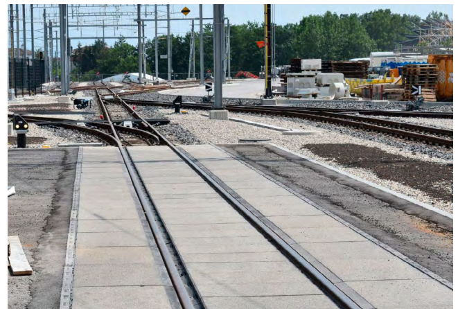
Gleisabschnitt mit Bodan-Platten
