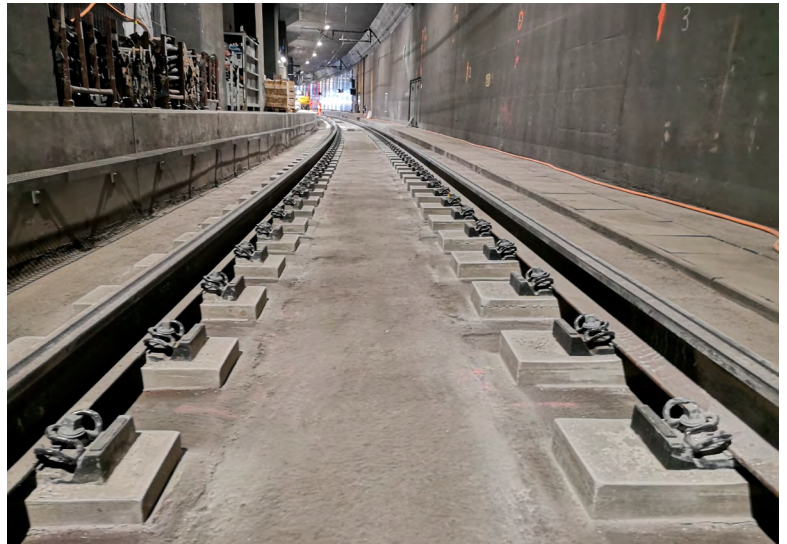
Die neue feste Fahrbahn mit Direktbefestigungen auf Beton- bzw. UHFB-Sockeln wurde in der bestehenden Gleisstragplatte eingebaut.
