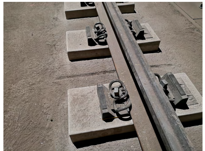
Die neue feste Fahrbahn aus UHFB
