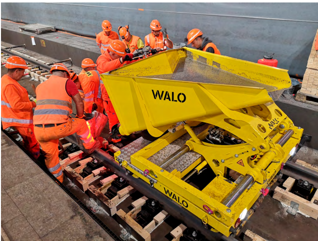
Ausgossen vom Beton- bzw. UHFB mit dem Trichterfahrzeug
